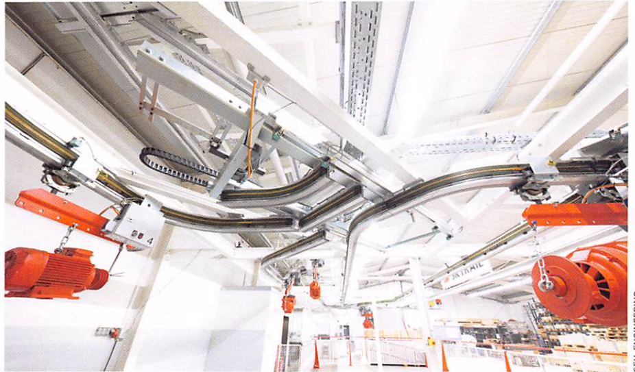
Die Elektrohängebahn „Skyrail“ von SEH Engineering GmbH verbraucht nur 20 bis 25 Prozent des Stroms einer klassischen EHB nach C1-Norm.
